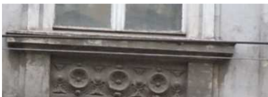
gzyms podokienny okna II piętra
