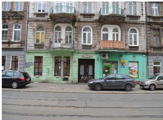
widok dolnych partii elewacji
