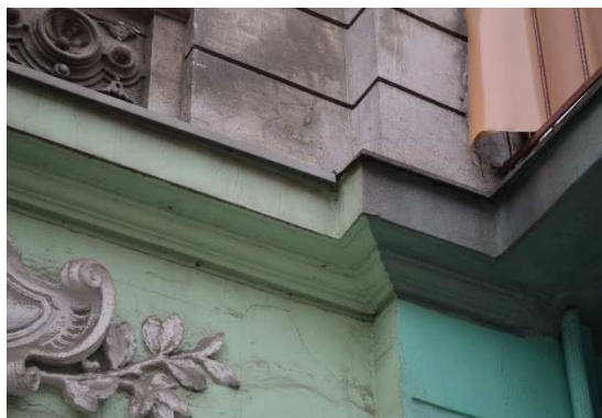
gzyms na wysokości stropu nad parterem
