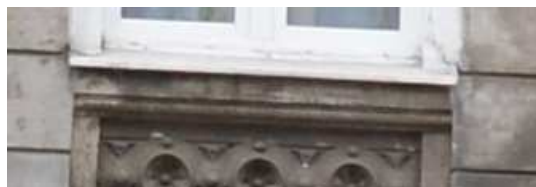
gzyms podokienny okna I piętra
