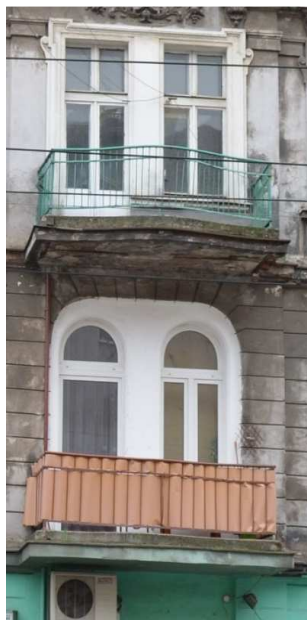
balkony osi 5,6, I i II piętra
