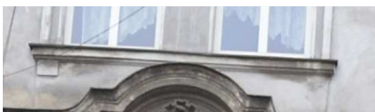
gzyms podokienny okien IV piętra
