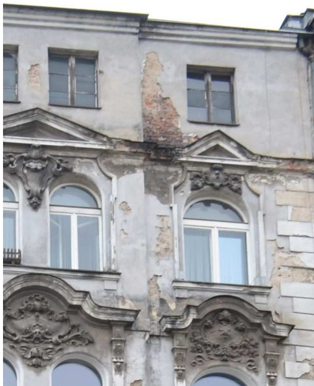
Ubytki tynków spowodowane nieuszczelnnością rury spustowej ubytki gzymsów i tynków górnej partii elewacji frontowej
