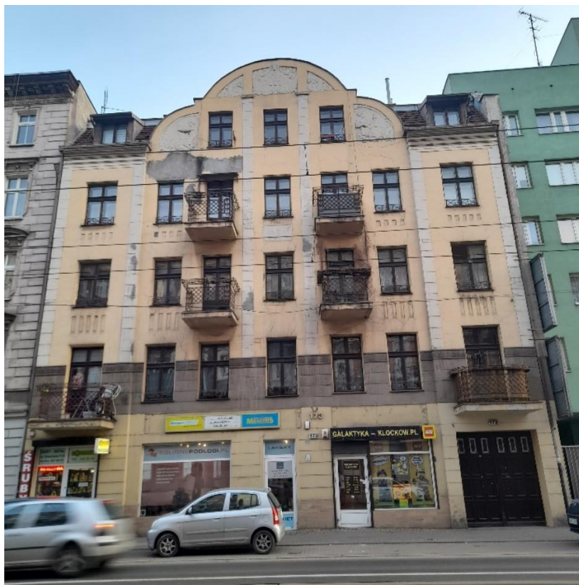
Fot. Elewacja frontowa, stan istniejący
