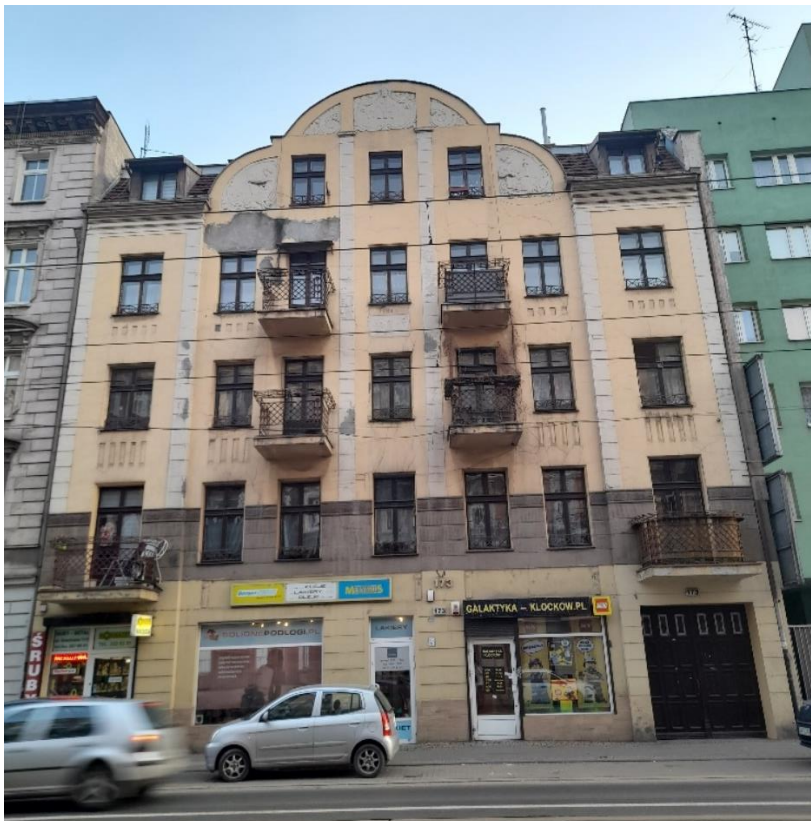
Fot. Elewacja frontowa, stan istniejący
