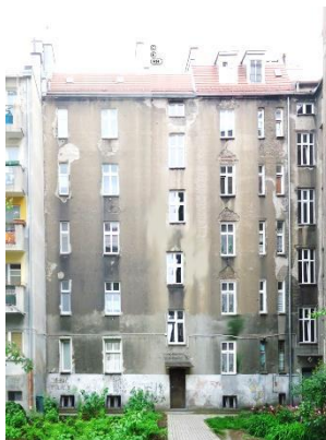
Fot. 2. Elewacja podwórzowa budynku
