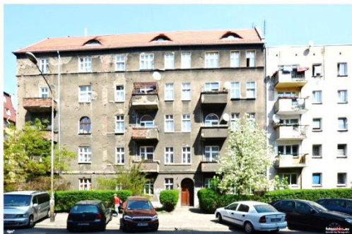
Fot 1. Elewacja frontowa budynku od ul. Orzeszkowej
