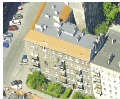
Fot. 3. Widok dachu z elewacją frontową
