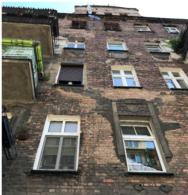
Foto. 1 Stan istniejącej elewacji
