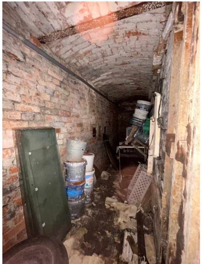
Fot. Piwnica, jedna z komórek lokatorskich
