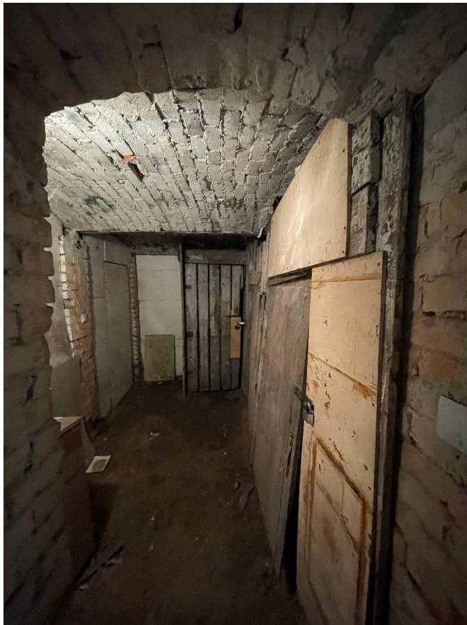
Fot. Piwnica, część wspólna
