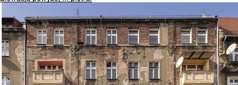
Widok elewacji III i IV piętra oraz gzymsu okapowego
