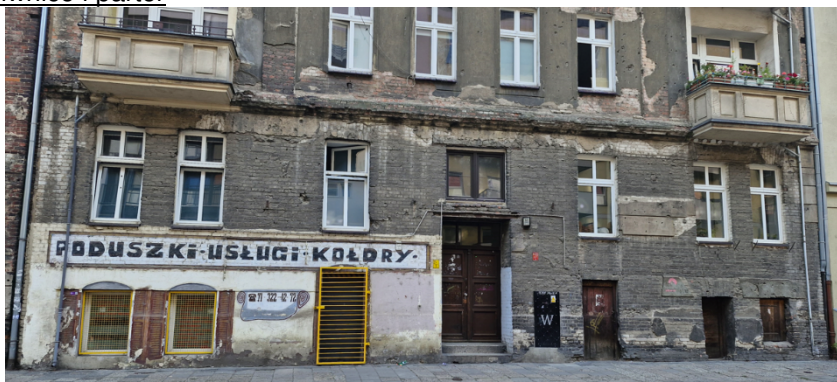
Elewacja frontowa – poziom piwnic i parteru
