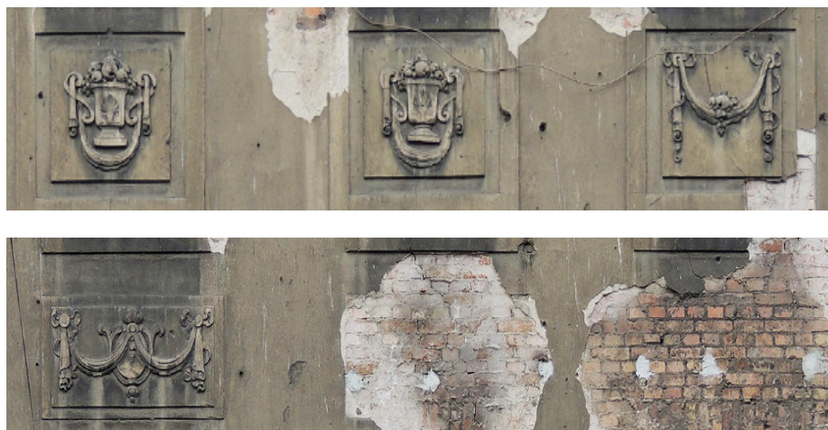
Zachowane dekoracje pasa między oknami II i III piętra.
