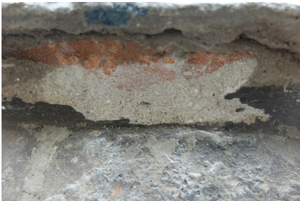
FOT. 17, 18 – Elewacja podwórza , ceglany cokół elewacji i przekrój tynku w miejscu odkrywki
