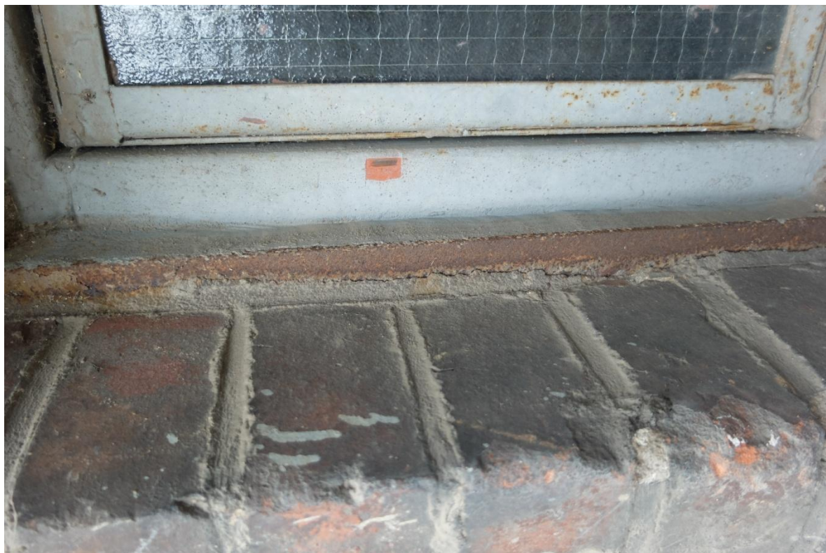
FOT. 19 – Elewacja podwórza, okno piwnicy, fragment.
