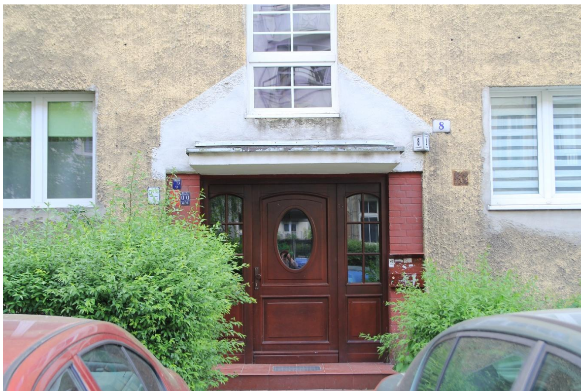
FOT. 3 – Elewacja frontowa – wejście do budynku, drzwi wtórne.
