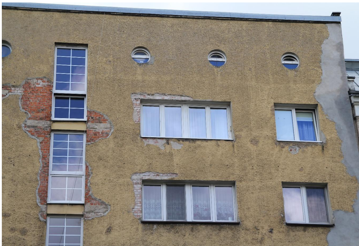
FOT. 1, 2 - Wrocław, Kraszewskiego 8 – elewacja frontowa, widok ogólny i fragment
