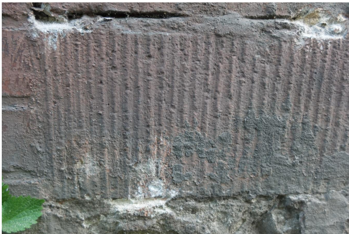
FOT. 8 - Elewacja frontowa, oś skrajna wschodnia – granitowa belka wmurowana w ceglane lico pod dawną witrynę.
