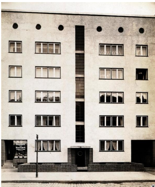
Elewacja frontowa, widok ogólny w latach 1928-29 https://polska-org.pl/3602119,foto.html
